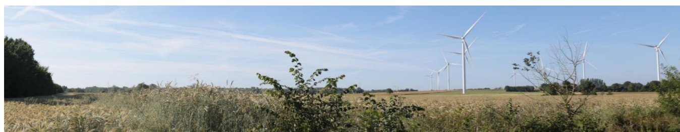
Photo 98 : Les implantations en ligne sont nombreuses au sein de l'aire d'étude éloignée – vue rapprochée du parc éolien de Glénay
